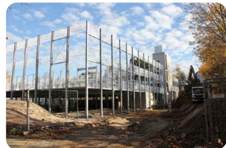
So sah es in der Bauphase noch vor wenigen Wochen aus.
