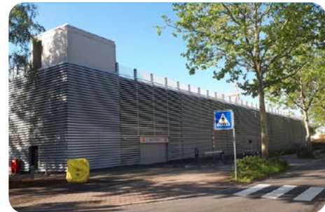
Das neue Hochschulparkhaus mit 445 Parkplätzen
